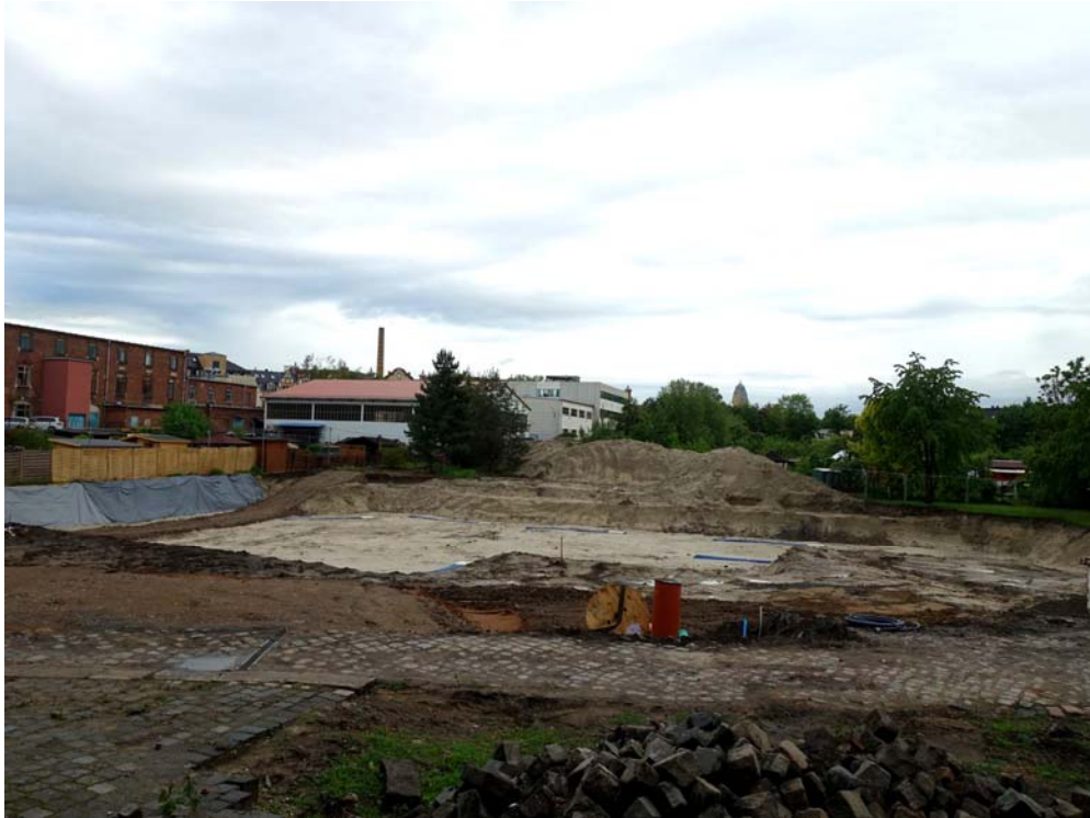
Noch eine Baugrube – im Herbst 2020 sollen die Wohnungen bezugsfertig sein. Foto: W. Schenk
