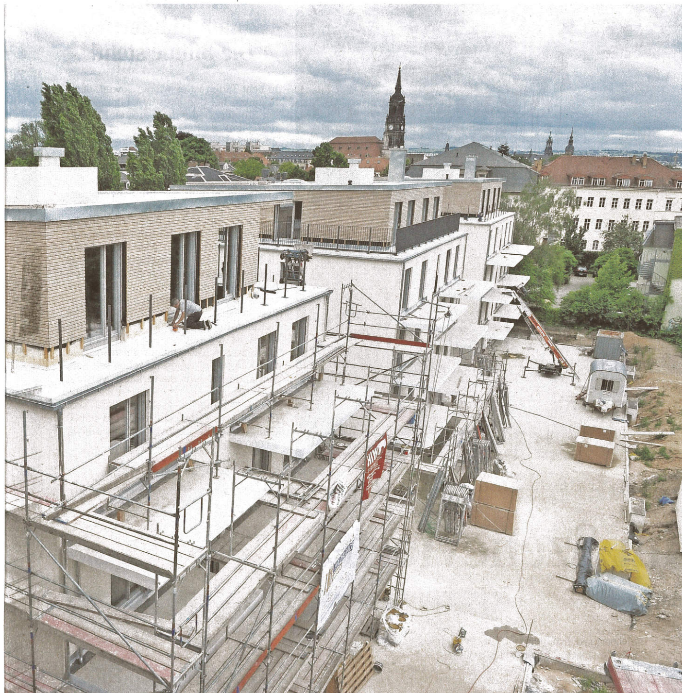
samer Tiefgarage, insgesamt 36 Wohnungen und zwei Gewerbeeinheiten empor gewachsen.
