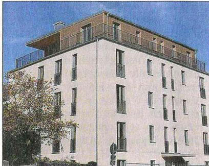
Während die unteren drei Stockwerke des Holzbaus wegen städtebaulicher Vorgaben mit Mineralputz versehen sind, ist das Holz im oberen Stockwerk sichtbar. Das Tannen-/Fichte-Massivholz wurde im Außenbereich zum Witterschutz mit Lärche verkleidet.
